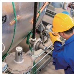
機器の据付及び試運転調整
